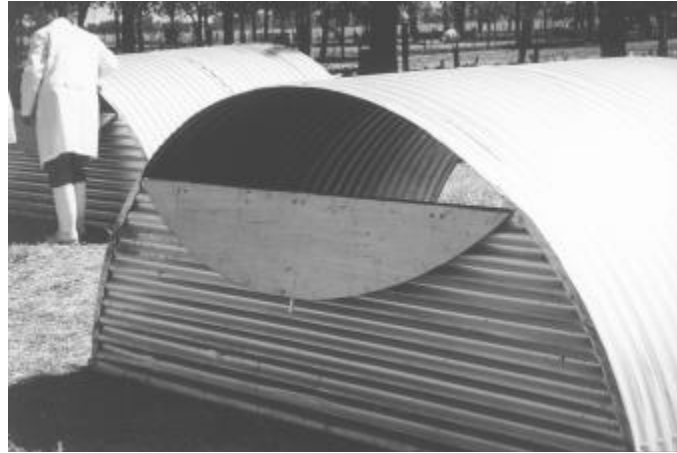
Figura 10 b: Paridera arco. Detalle de la ventana posterior.
